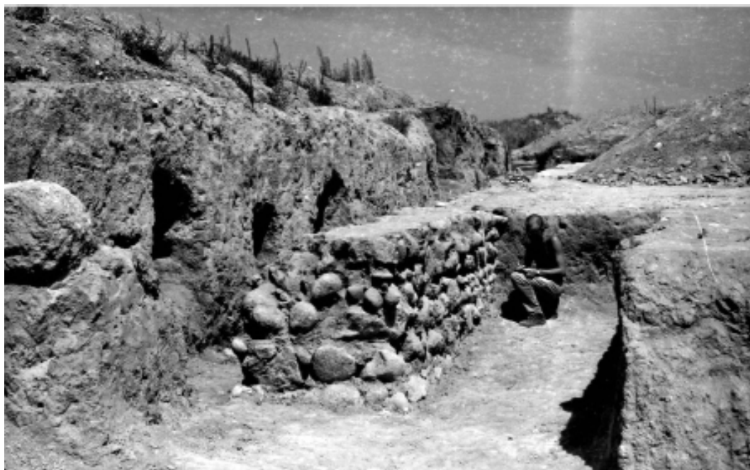
Рис. 14. Фундамент стены мечети.
