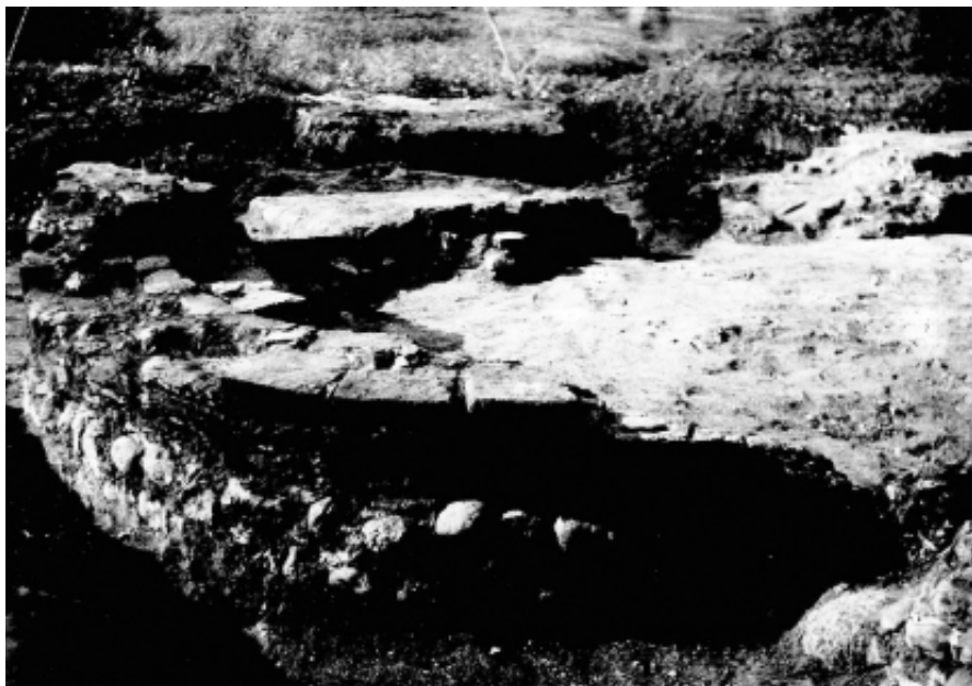
Рис. 32. Церковь 4, Фундамент и кладка апсиды
